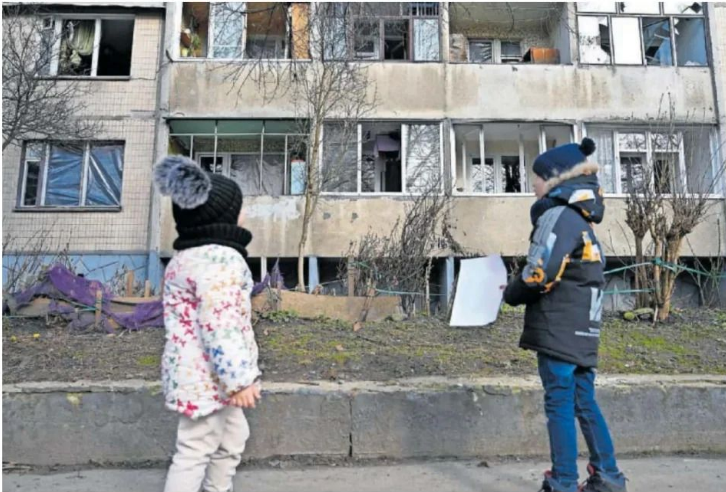
Dos niños jugaban el jueves frente a un edificio afectado por la onda expansiva de las bombas en la región de Lviv. ANASTASIIA SMOLIENKO (GETTY)
